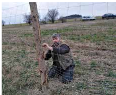
16.3. a 25.3. 2021 – zavětrování kůlů a oplocování pozemků lesnickým pletivem
