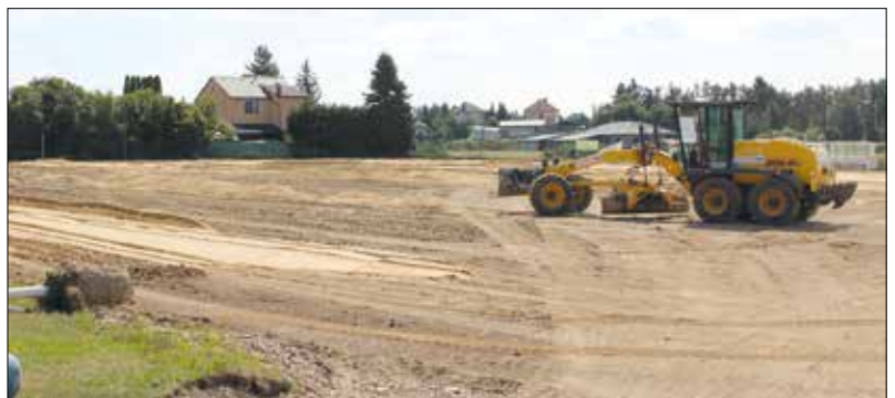
Rovnoměrné srovnání písku graderem
