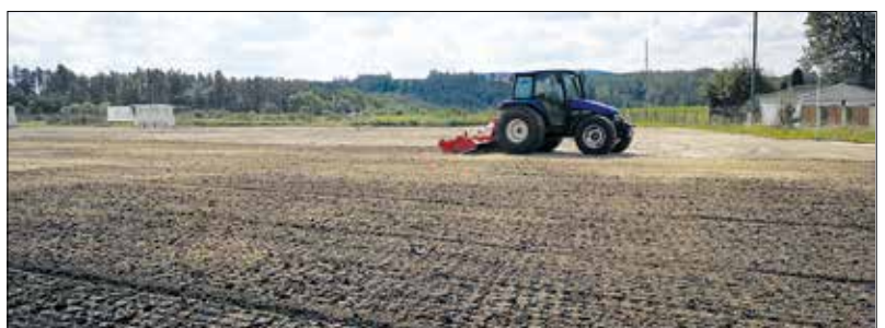
Strojové promíchání písku a substrátu
